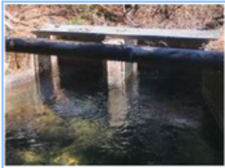
DS Canal Shotgun Culvert - Red Dog Rd
