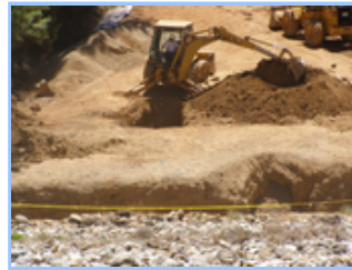
Dutch Flat Forebay Repair.JPG
