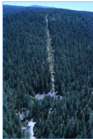
2008-06-19 Deer Creek Penstock 007.jpg
