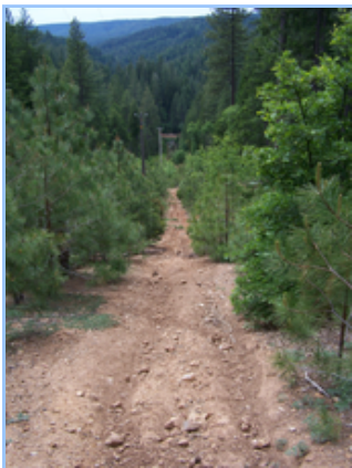
2008-06-03 Deer Creek Penstock 011.jpg
